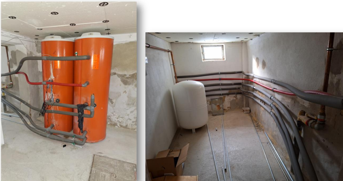
Abb. 5: Provisorium während der Umbaumaßnahmen zur Aufrechterhaltung der Trinkwassererwärmung
