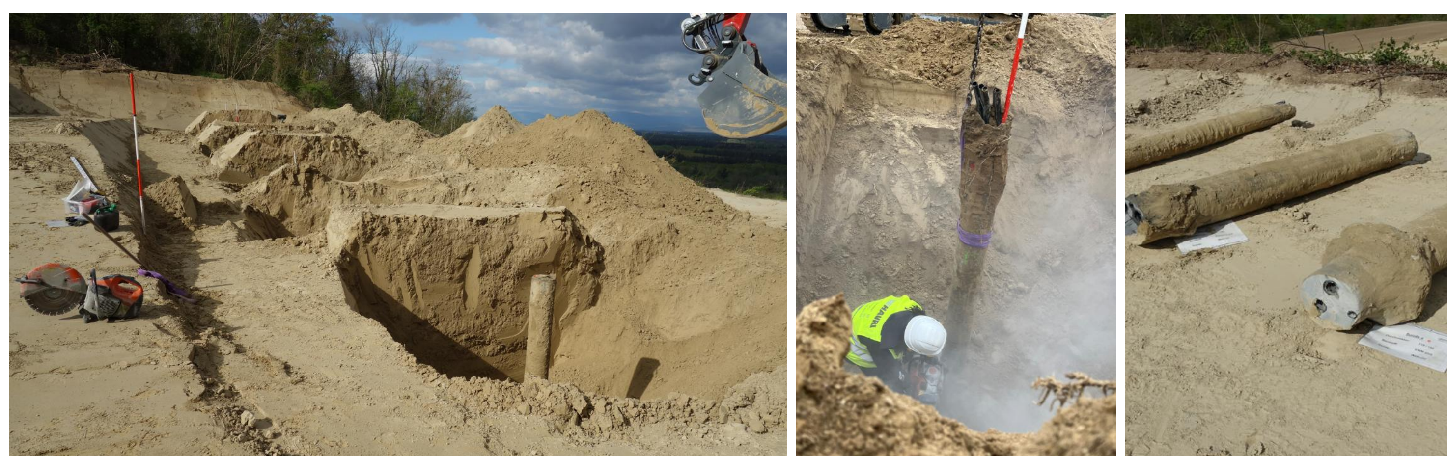
Abbildung 5: links - schichtweise Freilegung der EWS-Bauwerke in einem Steinbruch
