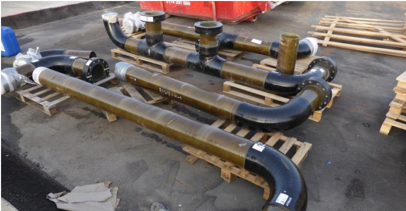
Abb. 5: Angelieferte GFK-Rohre auf der Baustelle des Geothermie-Heizwerkes in Poeldijk
