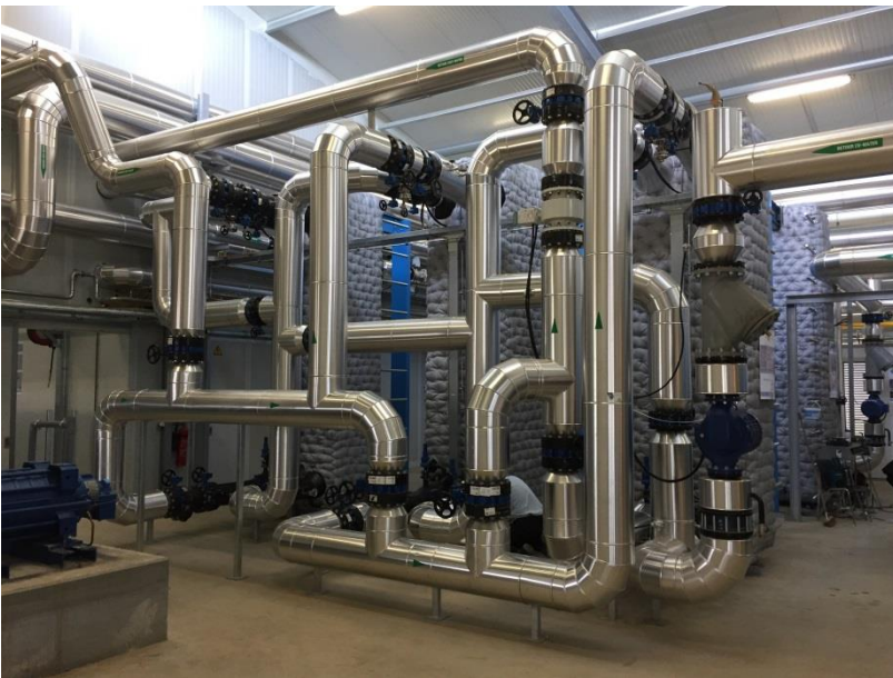
Abb. 2: Ausschnitt aus der fertigen Anlage mit den 4,5 Meter hohen und 6,5 Tonnen schweren Wärmeübertrager nach erfolgter Installation im Gebäude.
