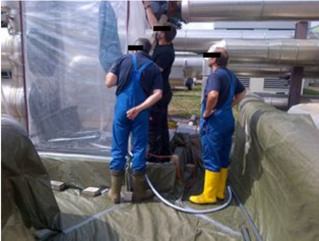
Abb. 2: Aufbau von Spritzschutzkabine und Folienauskleidung zur Vermeidung von Kontaminationsverschleppung
