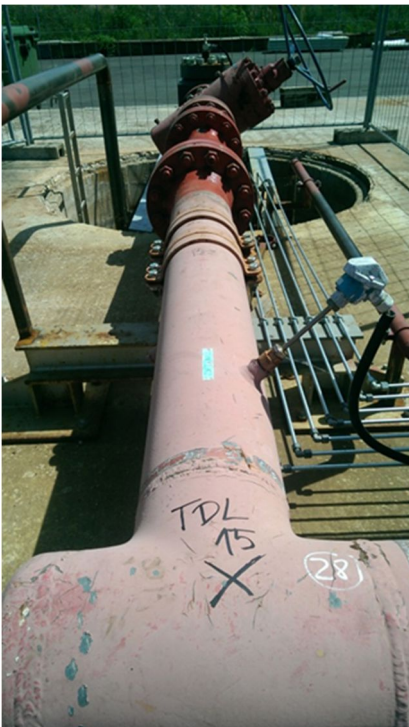
Abb. 1: Beispiel eines Messpunktes für wiederkehrende Messungen der Ortsdosisleistung am Thermalkreis
