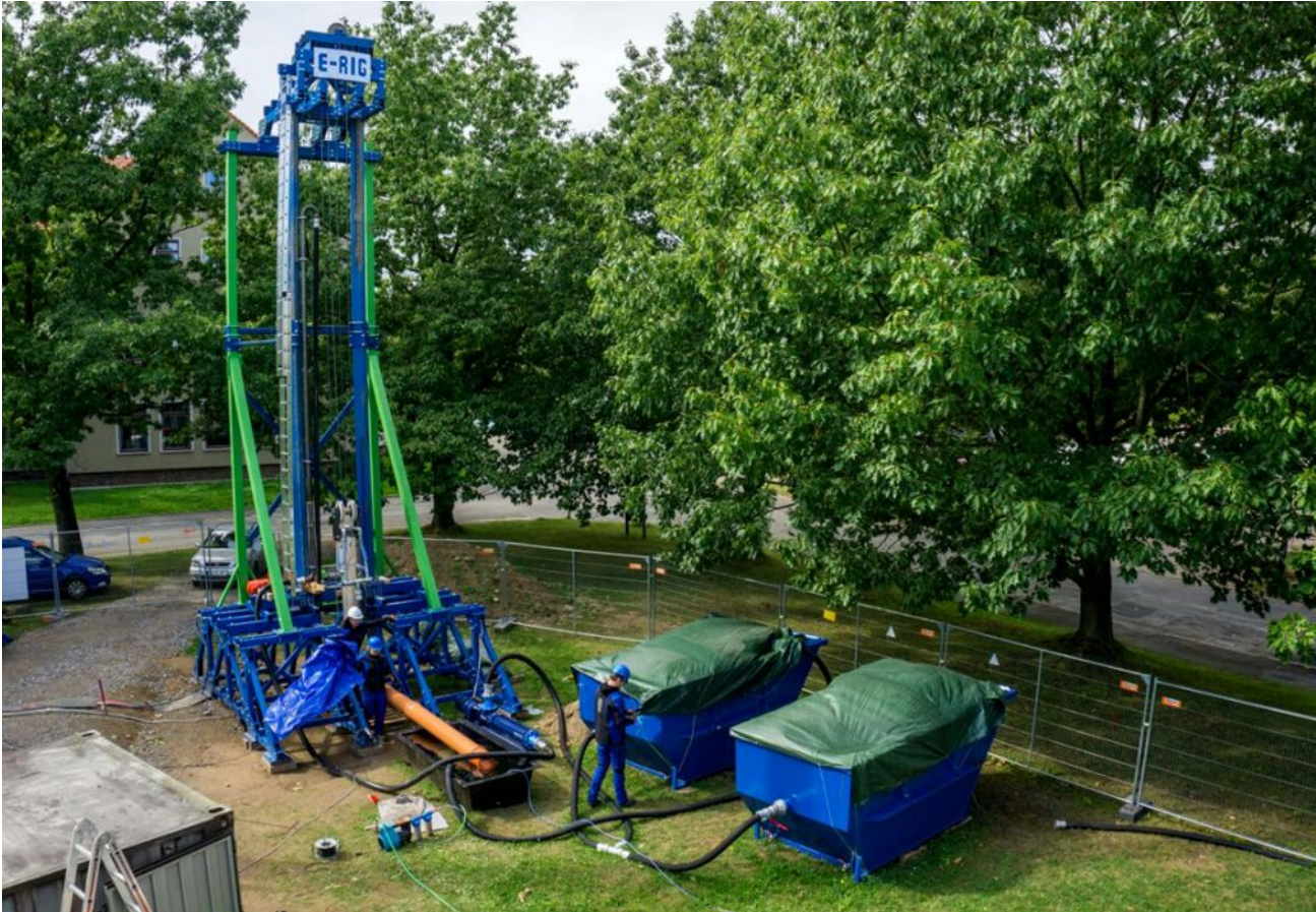
Abb. 7: Bohranlage auf dem Campus der TU Bergakademie Freiberg
