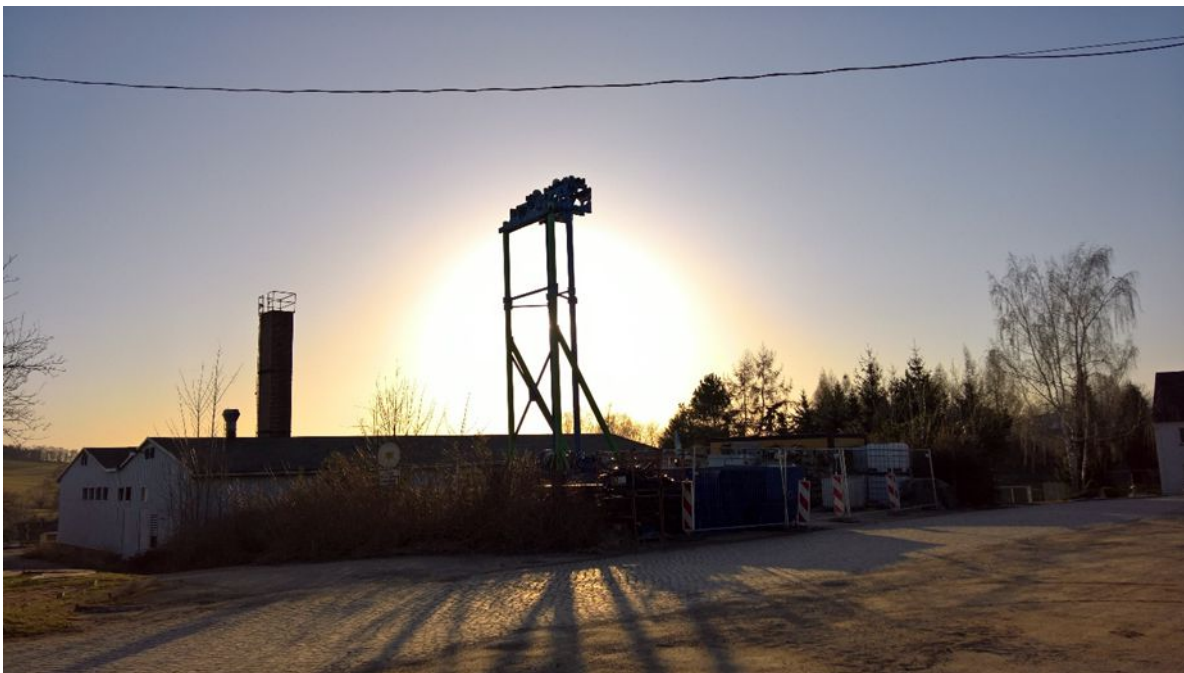
Abb. 8: Bohranlage am gegenwärtigen Standort nahe Freiberg
