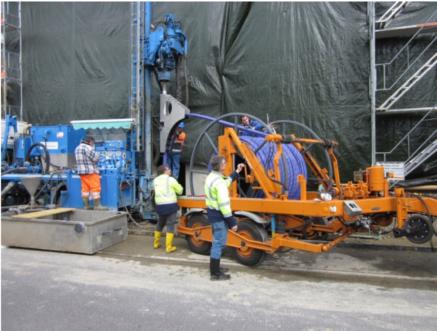
Abb. 13: Einbau der GEROtherm® KOAX Erdwärmesonde
