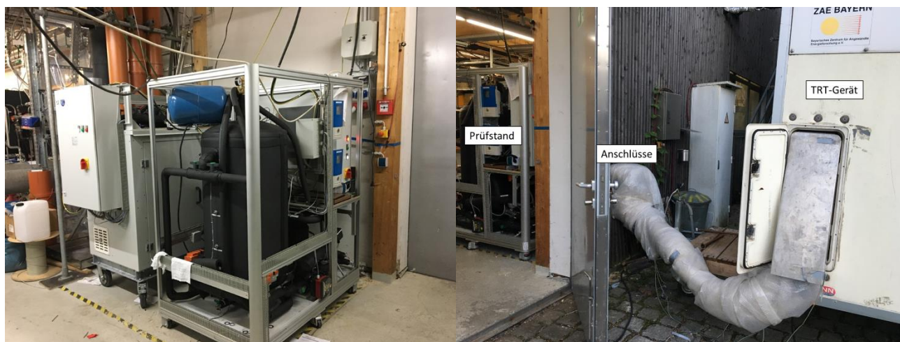
Abb. 2: links: Fertig aufgebauter Prüfstand; rechts: TRT-Gerät an künstlicher Erdwärmesonde angeschlossen.
