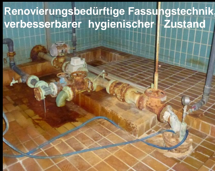
Sinter in Rohrleitungen
