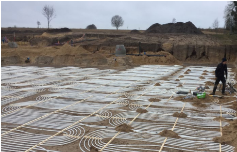
Abbildung 1 + 2: Leitungsverlegung Rieseby, Erdkollektor
