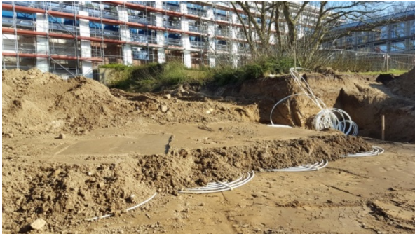
Abbildung 1: Erdkolektor in Sandwichbauweise
