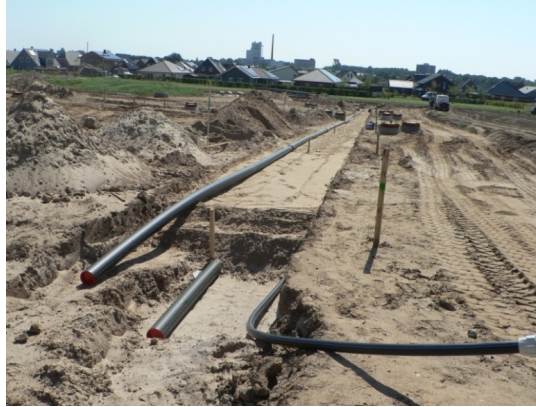
Abbildung 1 - 3: Leitungsverlegung Kalte Nahwärme, Berender Redder, Schleswig
