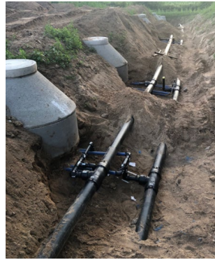
Abbildung 1 + 2: Leitungsverlegung Rieseby, Erdkollektor
