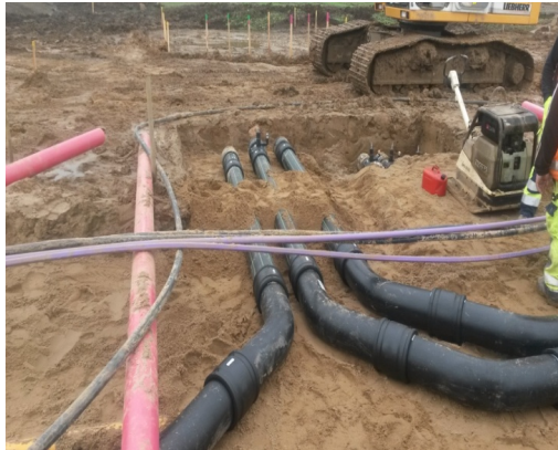
Abbildung 1 - 3: Leitungsverlegung Kalte Nahwärme, Berender Redder, Schleswig
